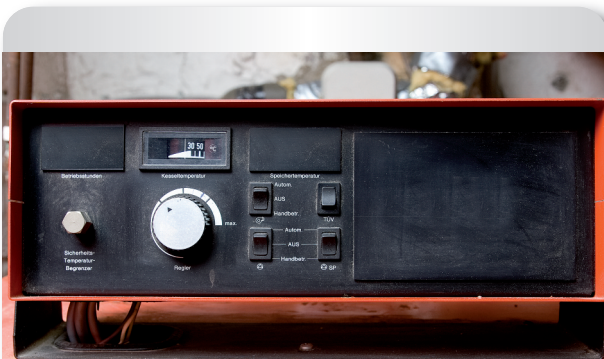
Kessel mit Kesselthermostat
