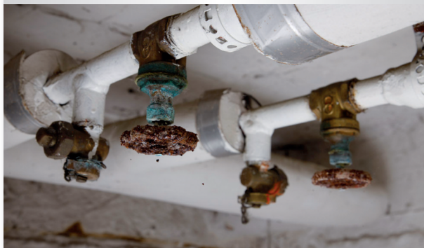
Fehlende Dämmung
