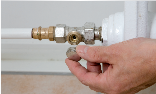
Prüfen der Voreinstellung an einer Rücklaufverschraubung
