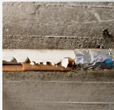
Defekte Rohrisolierung
