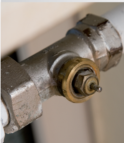
Altes Heizkörperventil
