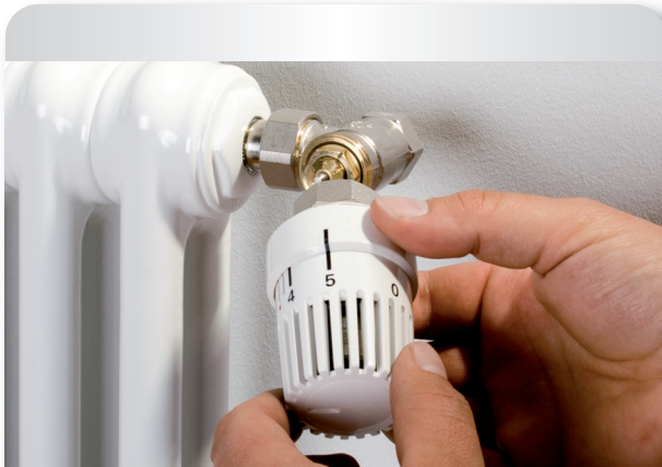
Prüfen der Voreinstellung an einem Thermostatventil
